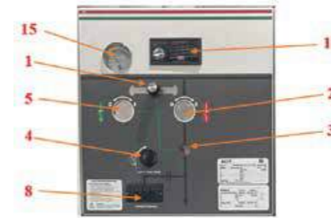
Mô-đun dao cắt tải | Load Break Switch module
